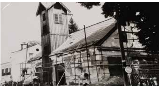
1977: Mit enormer Eigenleistung geschafft: Rüsthaus Sanierung und Erweiterung
